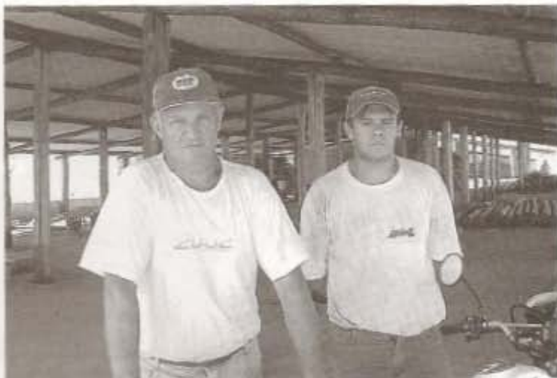
Pastel e seu filho Josué construindo o galpão
