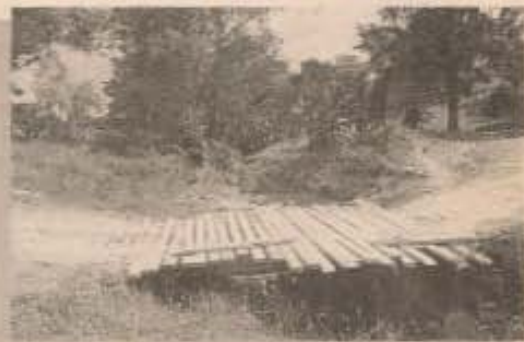
Ponte improvisada no Bairro dos Ilhéus
