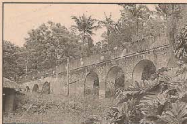
O aqueduto em perfeitas condições de uso
