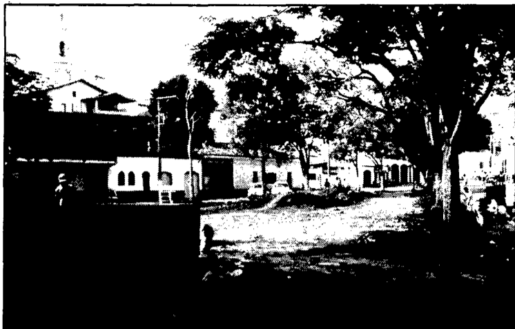
O Largo do Mercado em obras de recuperação
