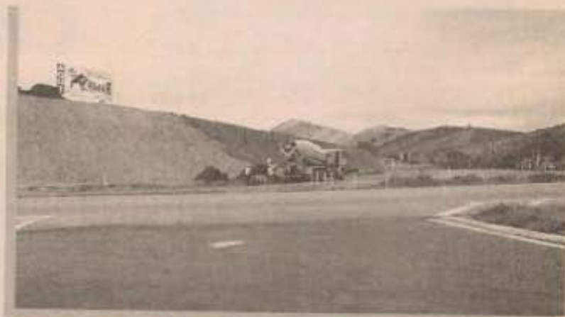
Trevo de entrada está sendo concluído
