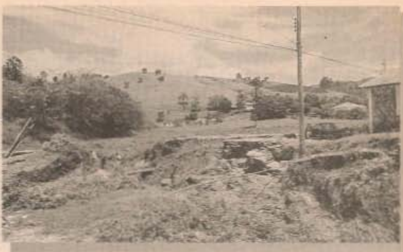
Ponte na Estrada da Laranjeira, também rodou.
