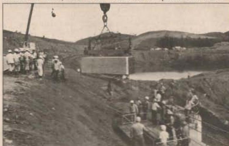
Operários colocam as peças de concreto que fechou o túnel.
